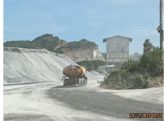
รูปที่ 3-23 ฉีดพรมน้ำบริเวณเส้นทางขนส่งแร่ หน้าเหมือง โรงโม่หินภายในพื้นที่โครงการ
